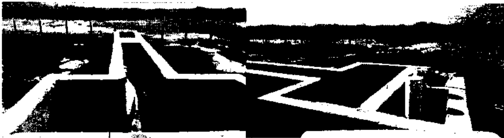
Fotografías No 1 - 6. Sistema de tratamiento de aguas residuales domesticas del municipio de Manaure compuesto por tres lagunas de oxidacion.
