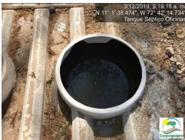
Fotografías No. 7 y 8. Recolección del agua y Rebose de aguas residuales domesticas ARD en los Tanques Sépticos Oficinas. CARBONES DEL CERREJON LIMITED – CERREJON. COMPLEJO MINA. 03 de diciembre de 2019. (Fuente: Corpoguajira 2019).
