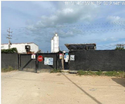
Foto 1. Entrada a la Planta de concreto 27/01/2021
