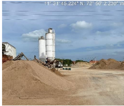
Foto 2. Vista al interior de la Planta de concreto 27/01/2021.
