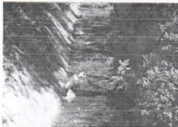
Escorrentías de aguas residuales en el canal de conducción de aguas lluvias
