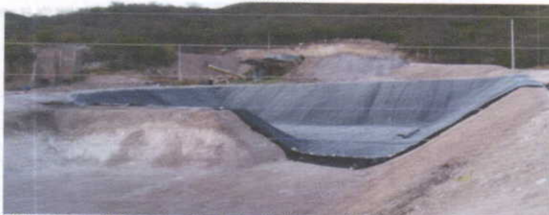
35 Metros Largo x 25 Mtrs Ancho x 7 Mtrs Profundidad impermeabilizada con geotextil y geomembrana
