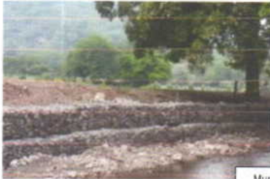
Muros en gaviones en el río Molino
