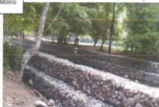
Muros en gaviones en el río Molino
