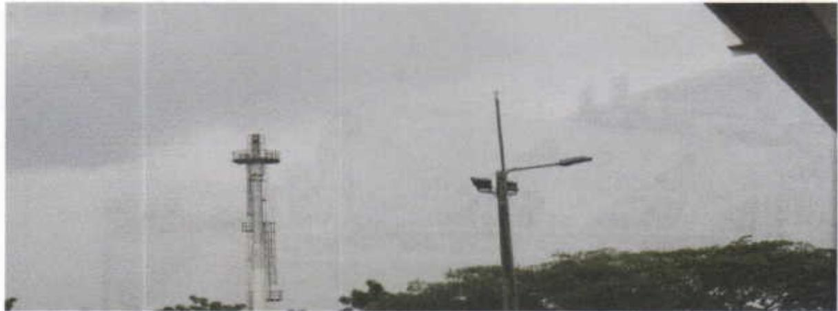
El diámetro de la tubería que va a la tea es aproximadamente de 20", la Tea tiene una altura aproximada de 30 metros y una zona de aislamiento o radio estéril superior a 50 metros, lo cual permite un tiempo de exposición infinita para personas y animales sin algún tipo de protección térmica. A este sistema están conectados más de 6 sistemas de tubería o subcabezales de venteo provenientes de la zona de SlugCatchers, Zona de Compresión, Zona de Enfriamiento del gas de descarga, entre otros.
