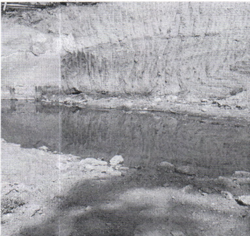
Imagen 3. Afloramiento y estancamiento de agua del Nivel Freático
