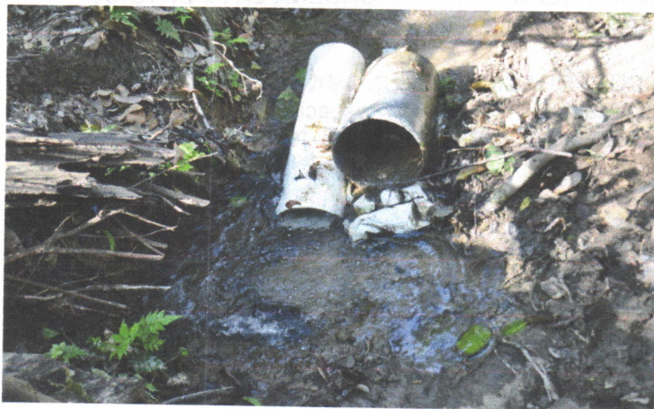
Tubo del Distrito de riego roto por rama de árbol talado
