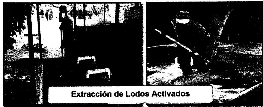
Se realiza con pala manualmente, teniendo cuidado de no contaminar el suelo con el lodo, el cual será dispuesto en una carretilla metálica, como se muestra en el registro. Una vez extraído el lodo se dispone hacer llevado a los potreros, el lodo solo se lleva en una carretilla para que sea incorporado al suelo una vez este mezclado con cal para neutralizar el PH y no se genere afectación ambiental negativa.
