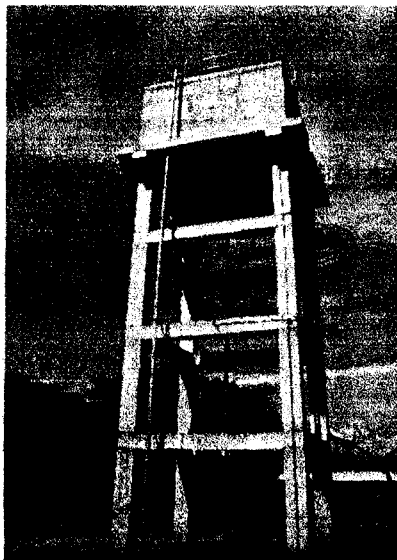
TANQUE ELEVADO DE DISTRIBUCION
