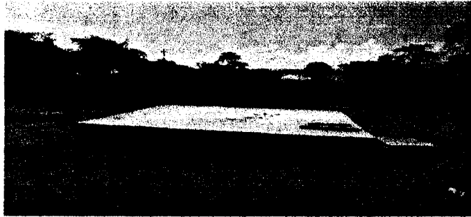
TANQUE DE ALMACENAMIENTO SEMIENTERRADO
