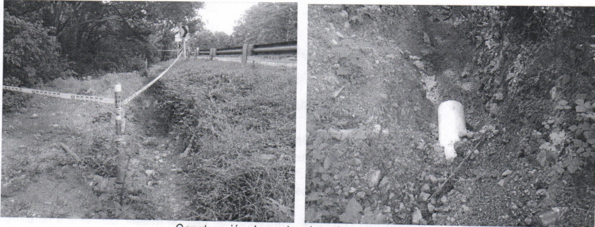
Construcción de zanja e introducción del tubo
