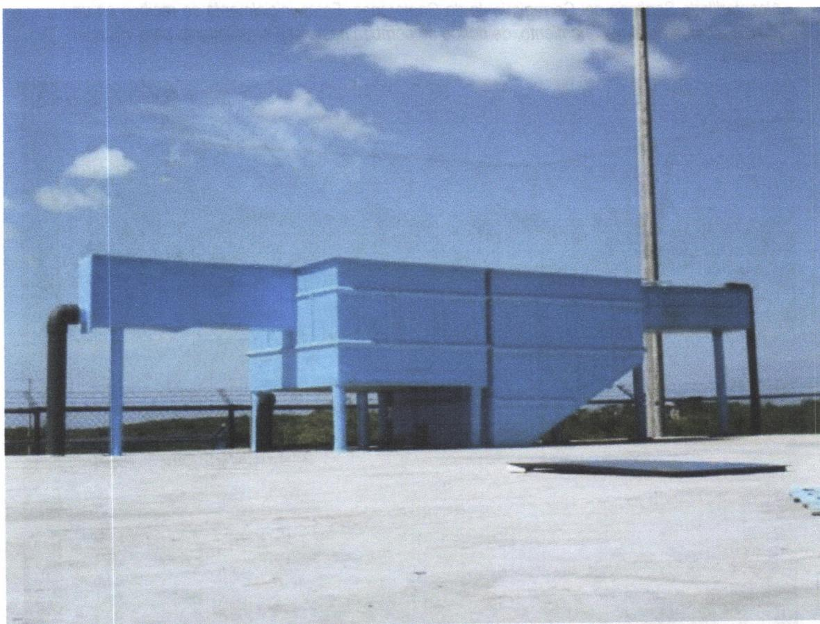
**Homogenización y Bombeo.** Este tanque o alberca se construyó con el propósito de establecer uniformidad tanto en las características de agua a tratar como en los caudales. Es un tanque completamente anaeróbico.
