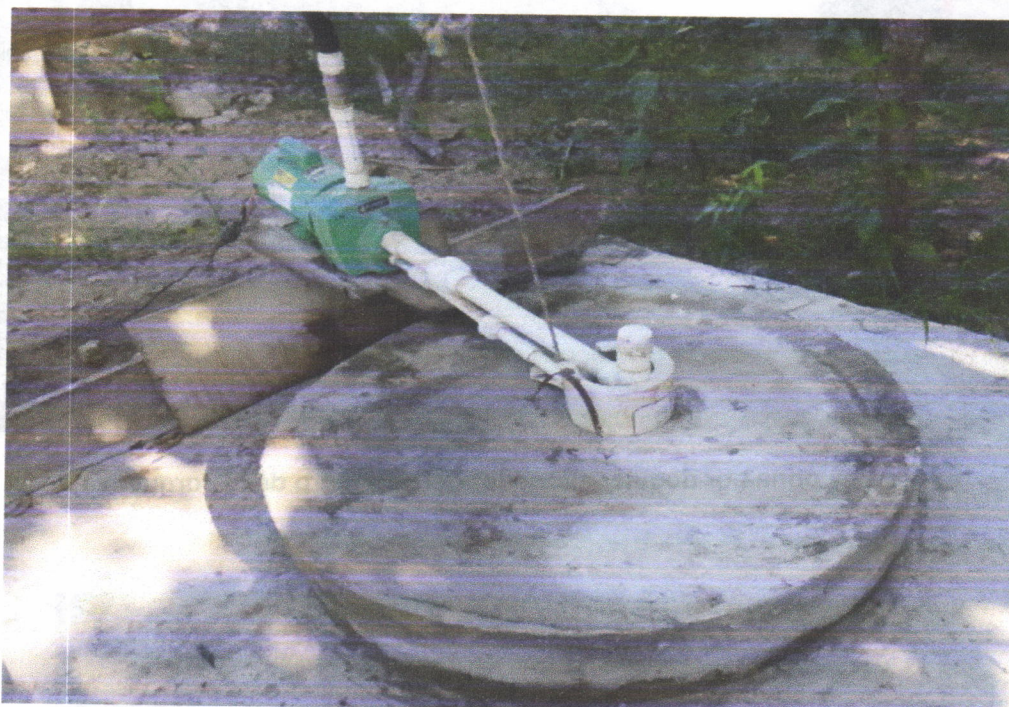
Pozo subterráneo sin permiso de CORPOGUAJIRA
