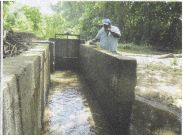
Imagen 8. Bocatoma lateral y válvulas de compuertas
