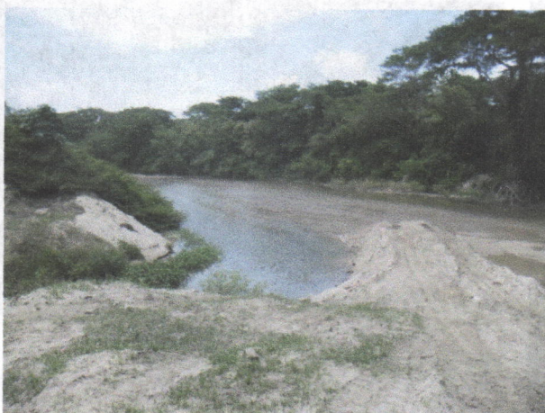
Imagen 15. Jarillón en tierra sobre el lecho
