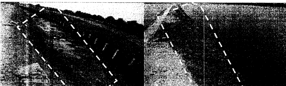
Fotografía No 7 y 8. Rebose e infiltración de aguas residuales desde las lagunas de oxidación del sistema de tratamiento de aguas residuales de Uribí hacia el exterior del sistema. Sistema de tratamiento de aguas residuales de Uribí. 07/06/2016.
