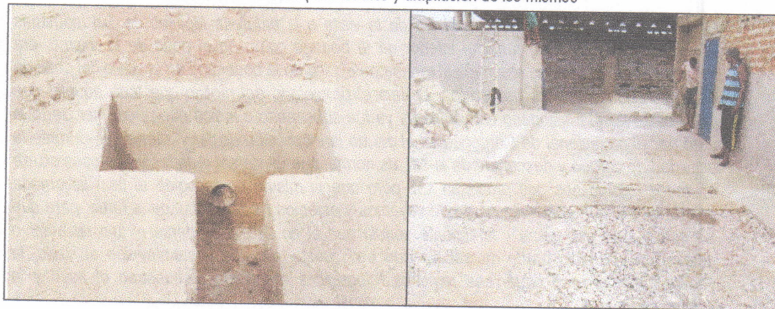
Fotos No 3: Canales perimetrales y ampliación de los mismos
