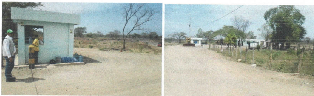
Garita e instalaciones de Cantera de La Florencia
