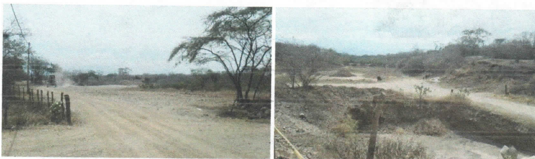
Panorama entrada a zonas de acopio Cantera de La Florencia – Corregimiento de Conejo, Municipio de Fonseca
