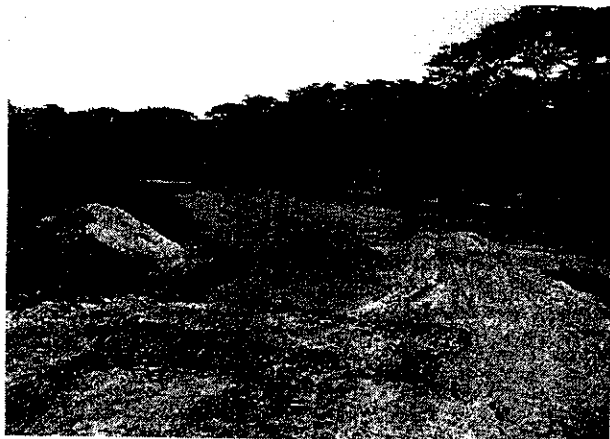
Imagen 15. Jarillón en tierra sobre el lecho
