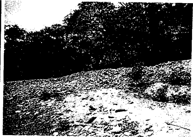
Imagen 10. Jarillón sobre el lecho del río Lagarto
