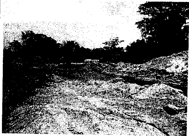
Imagen 24. Socavación y canalización del río
