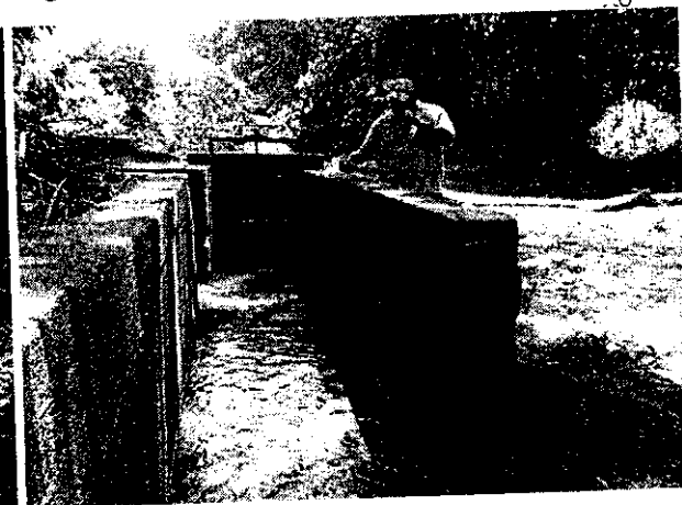
Imagen 8. Bocatoma lateral y válvulas de compuertas
