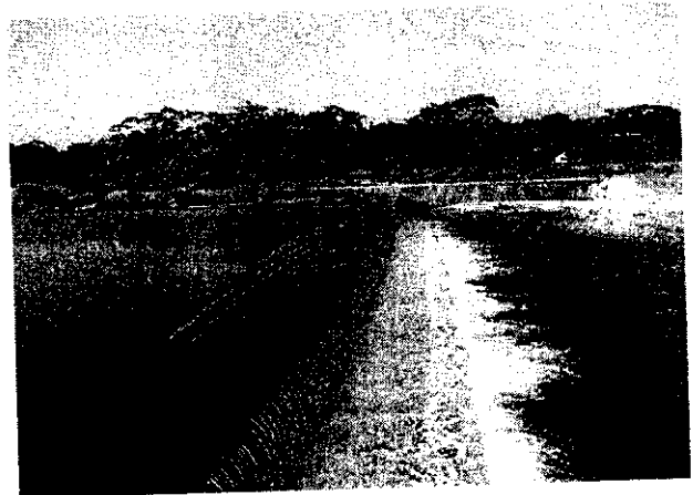
Imagen 12. Margen erosionada de la bocatoma
