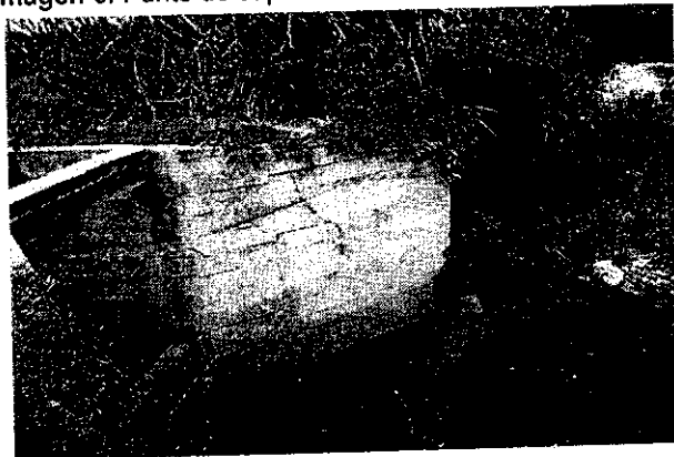
Imagen 6. Punto de captación con bocatoma lateral
