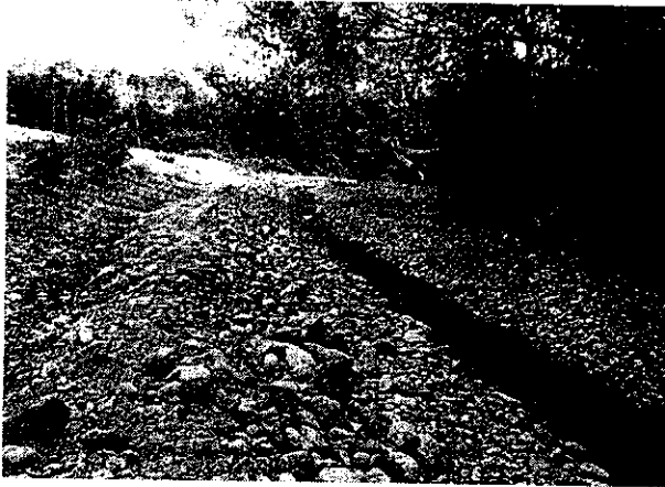
Imagen 9. Recaba para adecuación del canal
