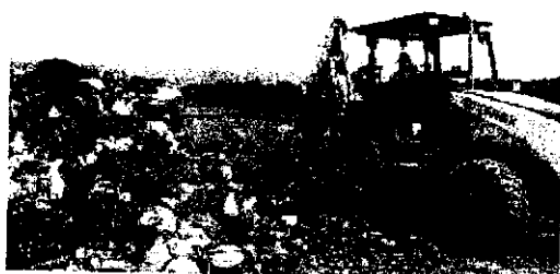
Foto No 46 y 47. Excavación parte superior celda No 3 para control de lixivios.
