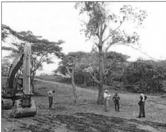
Maquinaria en el sitio de la queja
