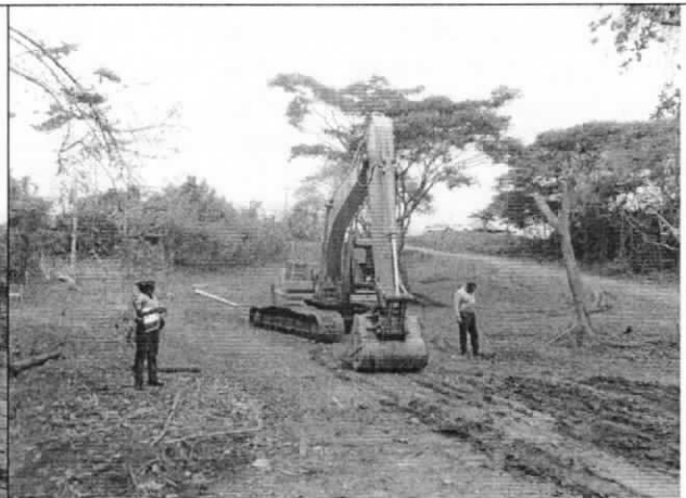
Verificación de podas e intervención
