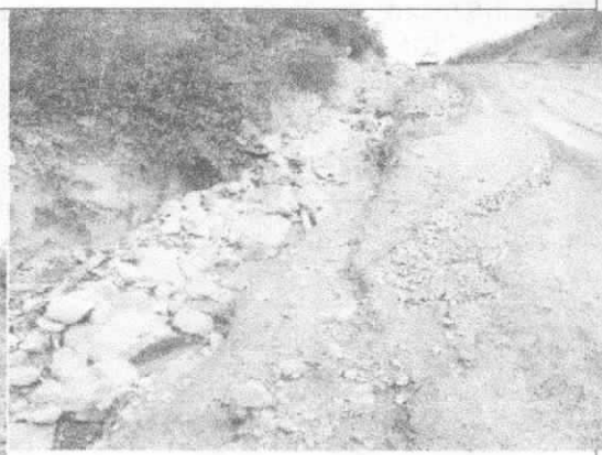
IMAGEN 12. CANALES PARA MANEJO DE AGUAS LLUVIAS CON PROTECCIÓN DE MATERIAL CON SOBRE TAMAÑO PARA DISMINUCIÓN DE LAS CORRIENTES DE AGUAS LLUVIAS
