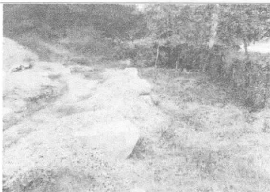
IMAGEN 13 MATERIAL CON SOBRE TAMAÑO PARA REDUCIR CORRIENTE Y RETENCIÓN DE SÓLIDOS
