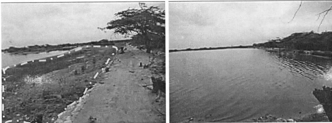
Fotografías No 1 y 2. Sedimentos y lodos compactados dentro de la laguna de oxidacion del municipio de maicao. Sistema de tratamiento de aguas residuales de Maicao. Seguimiento ambiental realizado el 26/05/2016.
