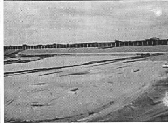
Fotografías No 13, 14, 15 y 16. Obras del nuevo sistema de tratamiento de aguas residuales de Maicao en abandono, membrana levantada, rota y taludes erosionados. 12/10/2016.
