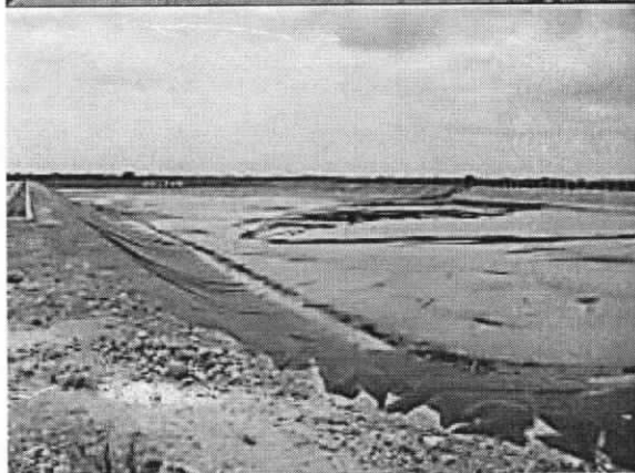
Fotografías No 13, 14, 15 y 16. Obras del nuevo sistema de tratamiento de aguas residuales de Maicao en abandono, membrana levantada, rota y taludes erosionados. 12/10/2016.
