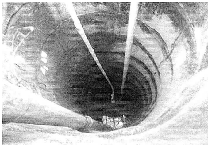
Foto 8. Pozo artesiano para captación de agua subterránea - AGREGADOS RÍO NEGRO. 28 de septiembre de 2017
