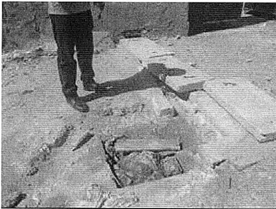
Fotografías N° 28 y 29. Cajillas cubiertas con escombros, arena y basura.
