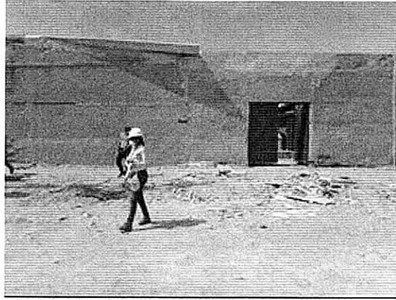
Fotografía N° 27. Parte trasera de la empresa INDUSALCA SAS.
