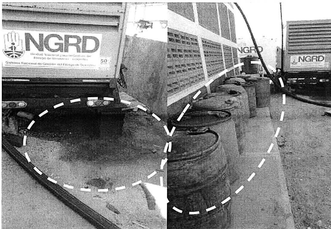
Fotografías No 7 - 11. Vestigios de derrames de hidrocarburos, filtros para aceites de motor y tanques de almacenamiento de hidrocarburos expuestos a la intemperie, ubicados en la estación de captación y acopio de agua denominada casa azul. Seguimiento realizado a la empresa Triple A Manaure en la fecha 08/05/2017.
