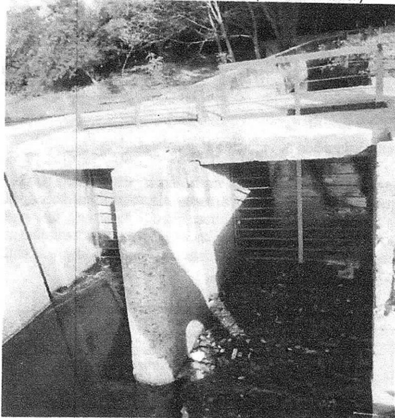
Fotografía 6. Bocatoma canal Robles (alta sedimentación)
