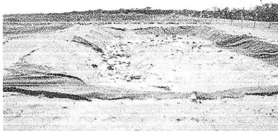
Fotos No 12. Lugar: Relleno Sanitario Manual de Manaure. Fecha: 2 de marzo de 2012. Laguna de lixiviados. Obsérvese la no presencia de lixiviados y el retiro o robo de geomembrana.
