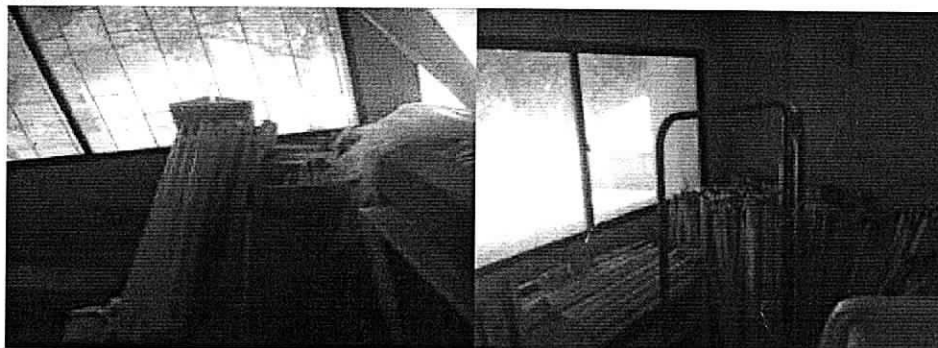
Fotografías No 8-9. Materiales inservibles y residuos peligrosos (luminarias) ubicados en la parte trasera del centro hospitalario. Hospital Nuestra Señora de los Remedios. (Seguimiento realizado en mayo de 2017)
