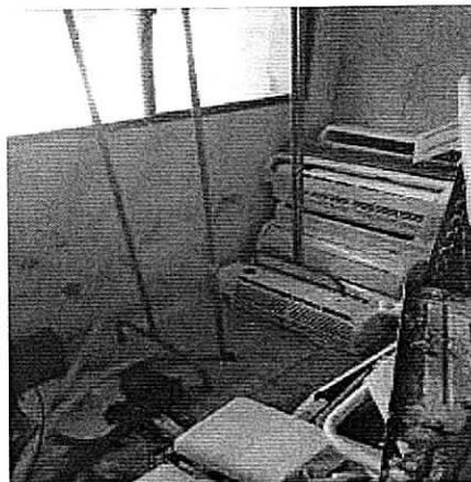
Fotografía No 10. Cuarto donde se almacenan luminarias y otros elementos.
