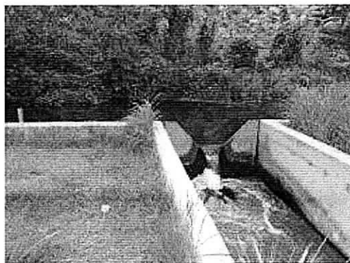
Foto 14. Punto de drenaje de presa. Vertedero y medidor de de caudal del agua infiltrada en la base de la presa. Proyecto Ranchería. Sept. 22de 2016
