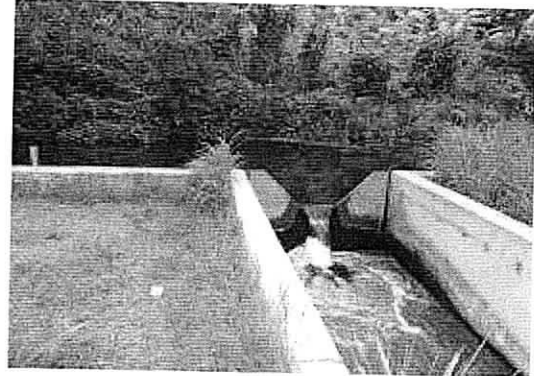
Foto 9 y 10. Punto de drenaje de presa. Vertedero y medidor de caudal del agua infiltrada en la base de la presa. Proyecto Ranchería. Sept. 15 de 2017
