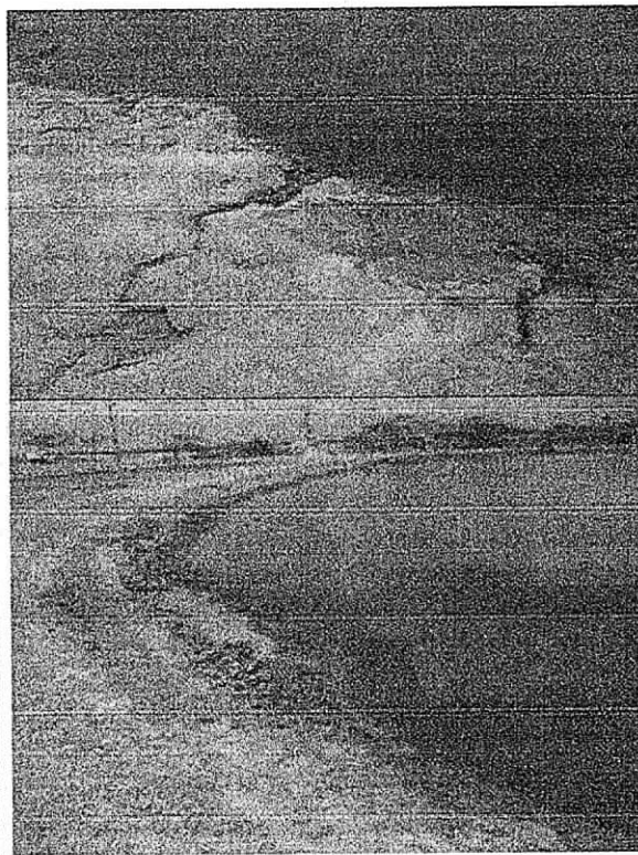
Fotografía No 3, 4, 5 y 6. Lagunas de oxidación sin revestimiento en los taludes, membrana impermeable y rebose de agua residual. Sistema de tratamiento de aguas residuales de Uribí. 07/06/2016.
