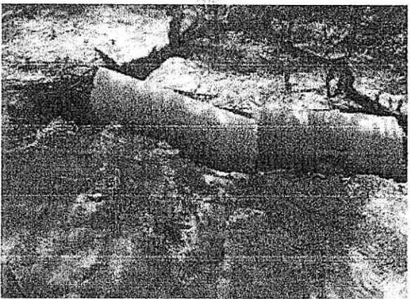
Fotografías No 9, 10, 11 y 12. Reparaciones en la tubería de conducción del agua residual hasta el sistema de tratamiento aguas residuales del municipio de maicao (Laguna de oxidacion). Sistema de tratamiento de aguas residuales de Maicao. Seguimiento ambiental realizado el 12/10/2016
