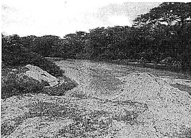
Imagen 15. Jarillón en tierra sobre el lecho
