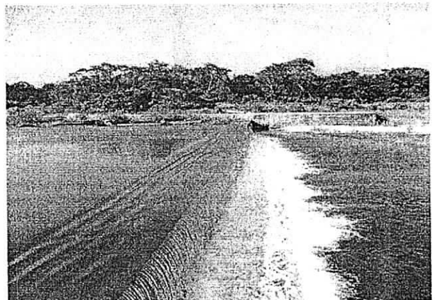
Imagen 12. Margen erosionada de la bocatoma
