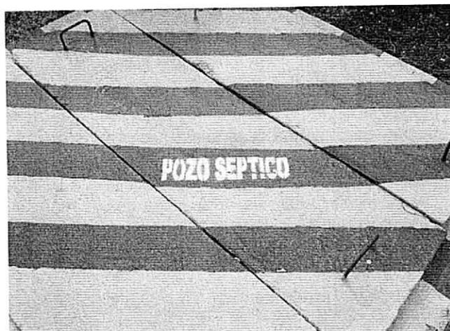
2. **Tanque Séptico:** En el tanque séptico se lleva a cabo la digestión y decantación del efluente en cámaras separadas. El período de retención está comprendido entre 1 y 3 días; durante este período, los sólidos se sedimentan en el fondo del tanque, en donde se tiene lugar una digestión anaeróbica, ayudada por una gruesa capa de espuma que se forma en la superficie del líquido, logrando la retención de sólidos biodegradables contenida en la materia orgánica.
