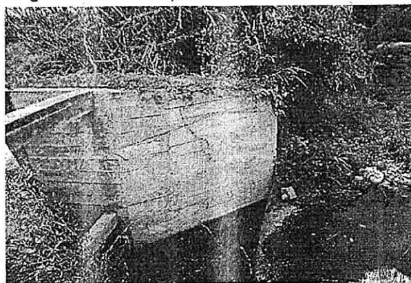
Imagen 6. Punto de captación con bocatoma lateral
