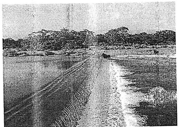
Imagen 12. Margen erosionada de la bocatoma
