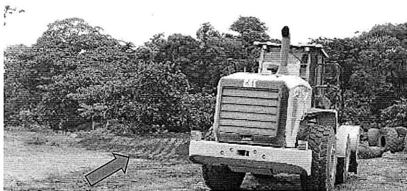
Nivelación del terreno para evitar el escurrimiento de aguas lluvias hacia el río
