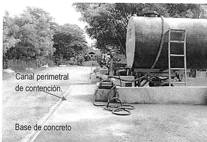
Tanque de combustible con su canal perimetral base de concreto y trampa.
