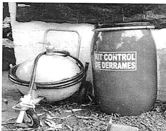
Kit de control de derrames ubicado a inmediaciones de los talleres y extintor ABC de 150 Libras.
