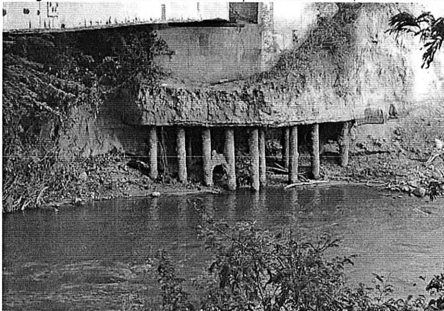
Fotografía 1 Alteración de la estructura del puente Casa e Tabla, estribo derecho
