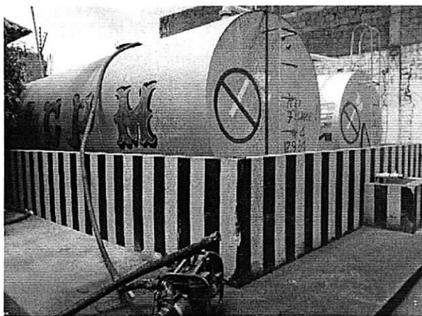
Foto 6: Bermas de contención de la EDS Combustibles KARY
