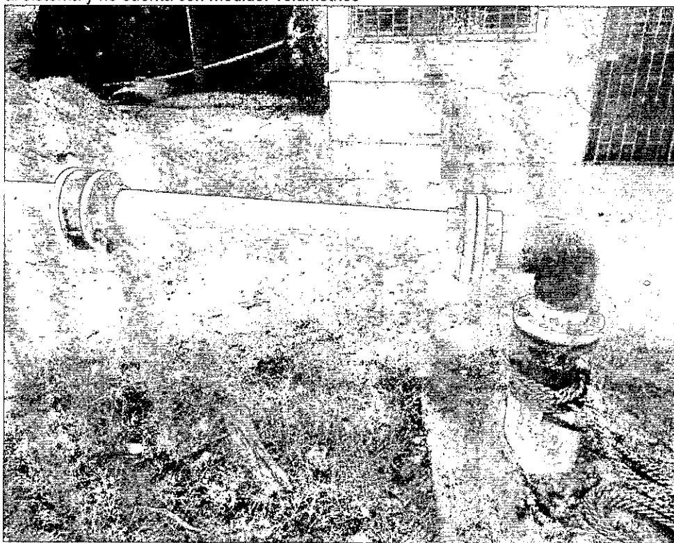
Imagen 9. Pozo No 5a construido dentro de la planta principal, este pozo es el que más agua aporta al sistema y no cuenta con medidor volumétrico
