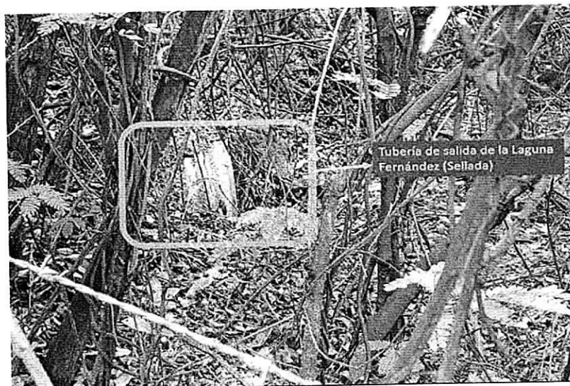
Foto 8: Tubería de la Laguna Fernández
