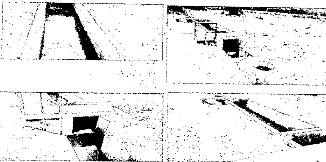
Imagen No 1 - 4. Canaleta de entrada al sistema de tratamiento, rejilla para filtrado que permite el ingreso de material sólido al sistema, una de las estridas al sistema se encuentra totalmente colmatado.
