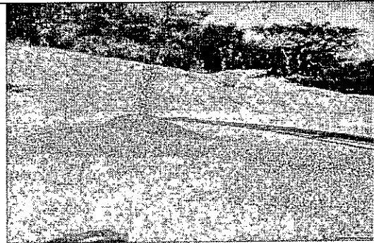
IMAGEN 5. CAÍDA DE MATERIAL TRITURADO CON CONTROL DE EMISIÓN DE MATERIAL PARTICULADO MEDIANTE SISTEMA DE HUMECTACIÓN
