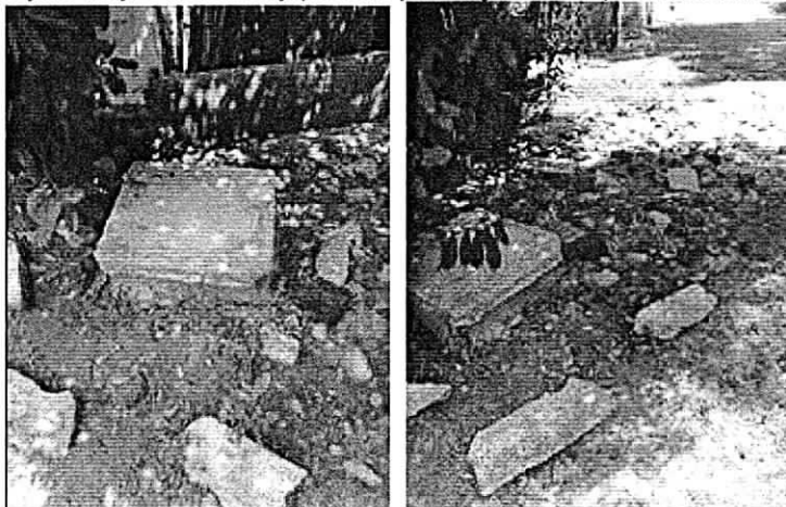
Fotografía #1 y 2: Cajilla o Manjol e inicio de zanja por donde pasa el agua residual que se desborda de las infraestructuras
