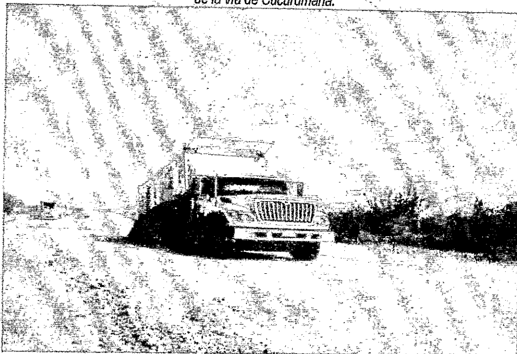
Fotografía 6 y 7: Suministro y colocación de material de recebo proveniente de cerro peralta para el terraplén de la vía de Cucurumana.
