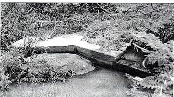
Fotografía No 7 - 10. Laguna que recibe las aguas residuales de los corregimientos de Papayal y Oreganal, presenta abundante vegetación que impide la visibilidad de las lagunas, colmatación del sistema de entrada y realiza vertimientos al suelo.
