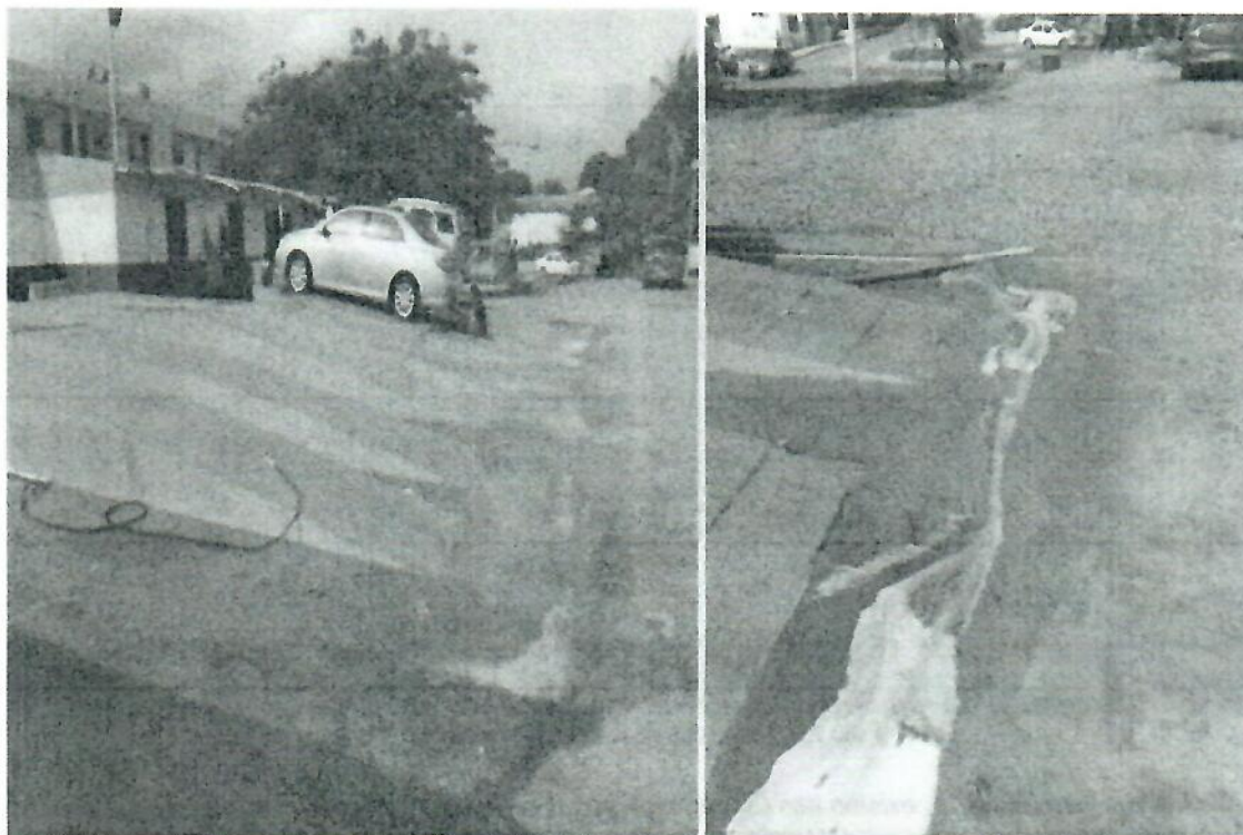
Fotos 10 y 11 : No hay presencia de canales o rejillas para la retención de arena
