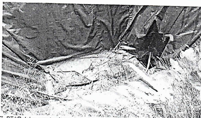
Fotografías No 5 - 7. PTAR del reasentamiento de la comunidad de Las Casitas, el agua residual es colectada en una alberca y transportada al sistema de tratamiento de aguas residuales del municipio de barrancas, el sistema no esta operando.
