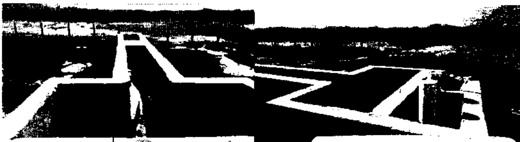
Fotografías No 1 - 6. Sistema de tratamiemo de aguas residuales domesticas del municipio de Manaure compuesto por tres lagunas de oxidacion.
