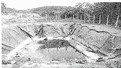
Foto No 25 y 26. Laguna de lixiviado No 4 con lixiviados pero deteriorada.
