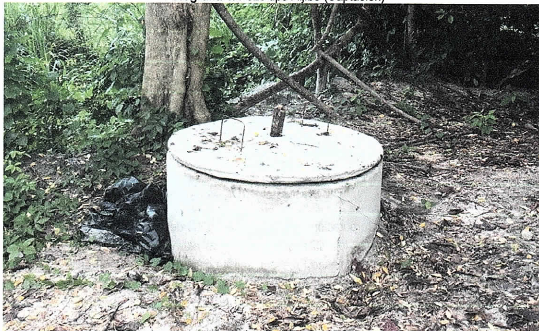
Fotografía 1. Pozo tipo Aljibe (Captación)
